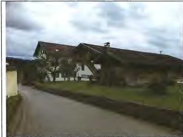
Abbildung 8 Blick von der Dorfstraße nach Süden auf das Baudenkmal innerhalb des Änderungsbereiches (Getreidekasten von 1819)
