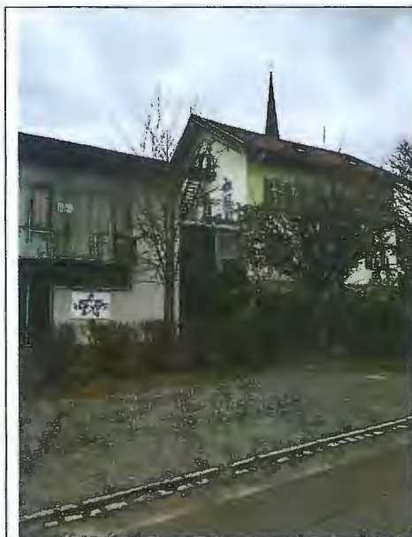
Abbildung 12 Blick von der Straße „Am Bergfeld“ nach Norden auf das Pfarramt (links), das Pfarrheim bzw. das ehemalige Schulhaus (rechts), und weiter dahinter die Kirche
