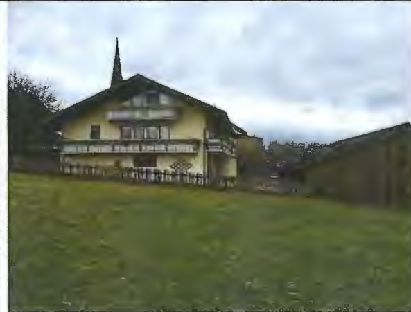
Abbildung 15 Blick nach Osten auf den südlichen Teil des Änderungsbereiches; mit der vorliegenden Planung wird das bestehende Wohnhaus mit zwei Quergiebeln ausgestattet bzw. das Dachgeschoss ausgebaut.
