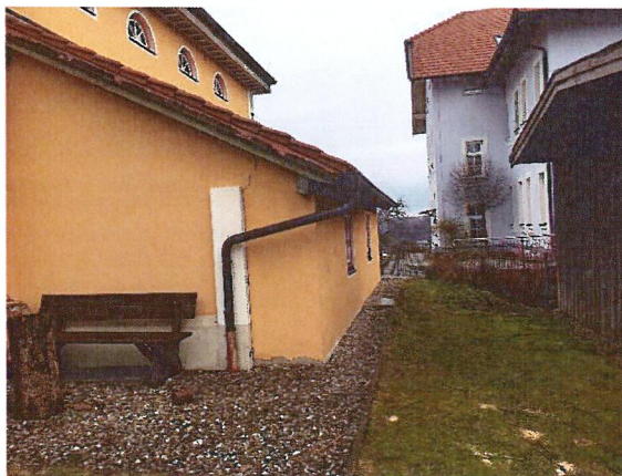
2e) Blick nach Osten auf die Nachbargebäude der östlichen Änderungsfläche: Feuerwehr links und Kindergarten geradeaus.
