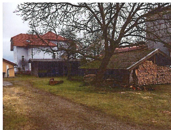
2f) Blick nach Südosten auf die östliche Änderungsfläche und die abzubrechenden Nebengebäude; hier ist eine Maschinenhalle geplant.
