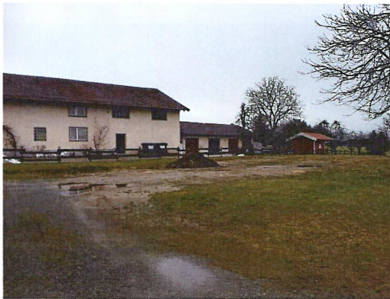
2a) Blick nach Nordwesten auf die Erweiterungsfläche; hier ist eine Lagerhalle geplant.
