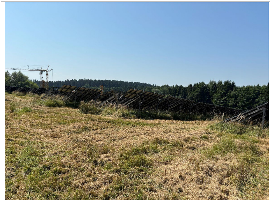
Bild 7: Blick nach Süden
