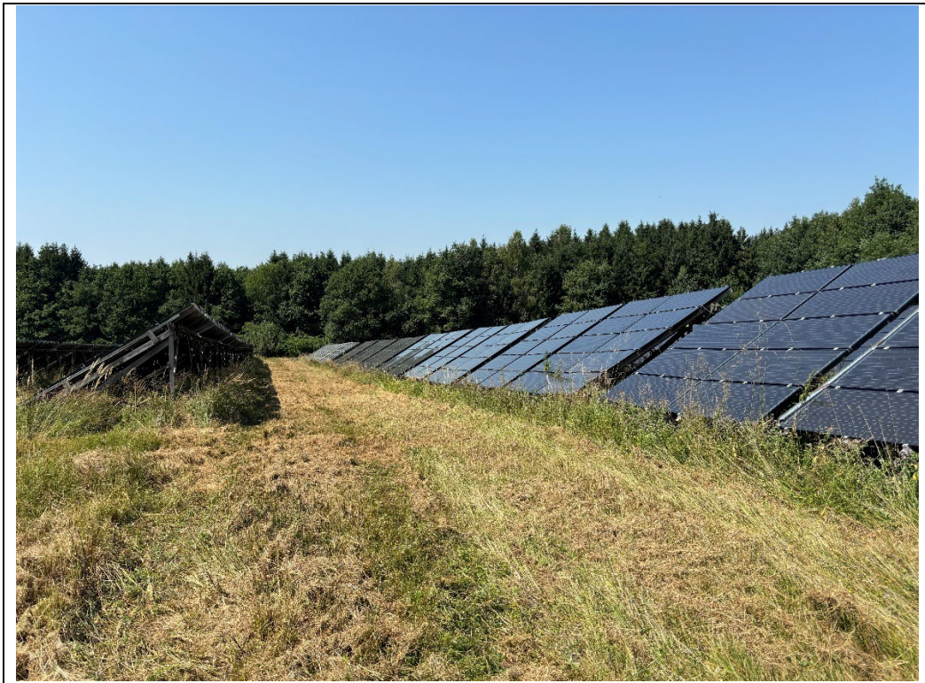
Bild 8: Blick nach Westen
