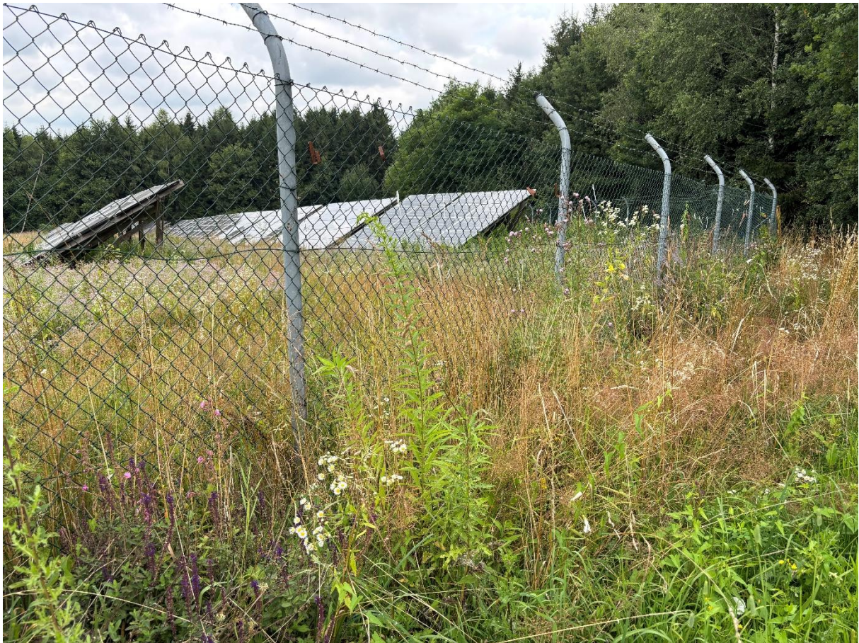
Abb. 12 Blick von Osten nach Westen auf die bestehenden Waldränder und die eingewachsene Einfriedung des Geltungsbereichs, Ortsbegehung Juli 2025
